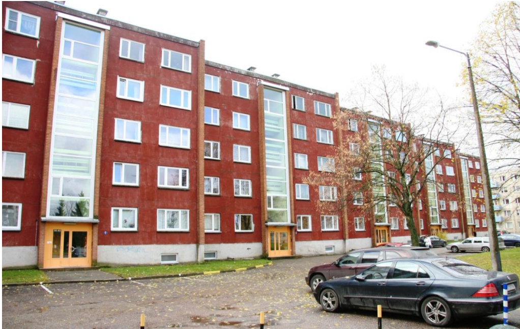
1. Hoone enne renoveerimist
