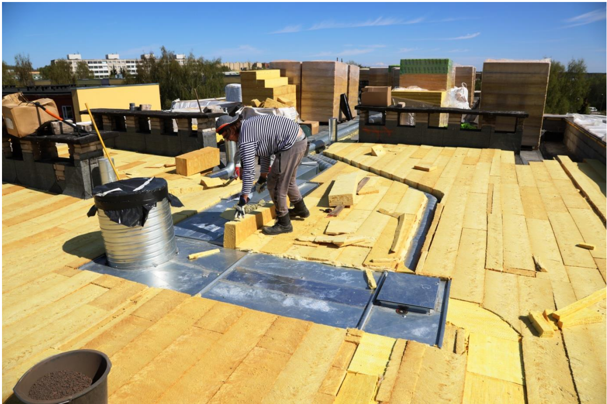
5. Ventilatsioonitorustiku paigaldus
