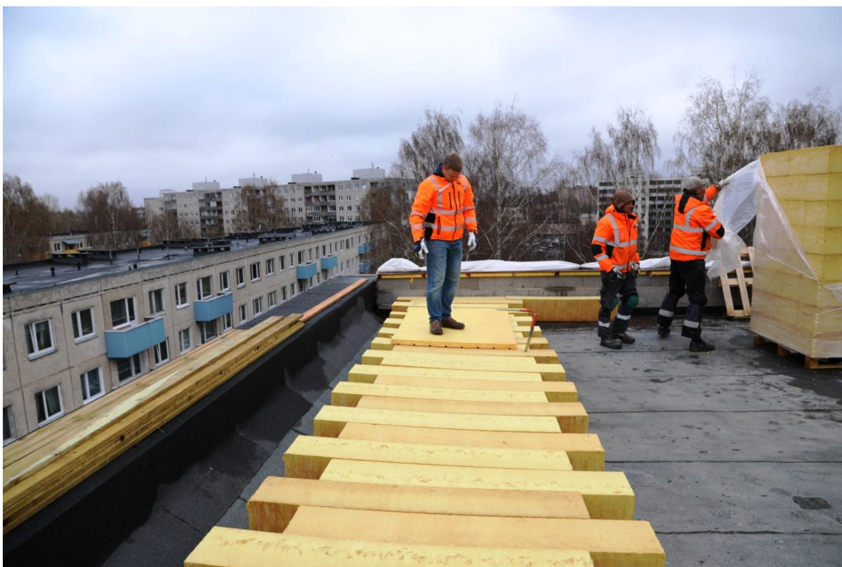
4. Vertikaalpaigaldusega lamellvilla paigaldus esimest korda Eestis.
